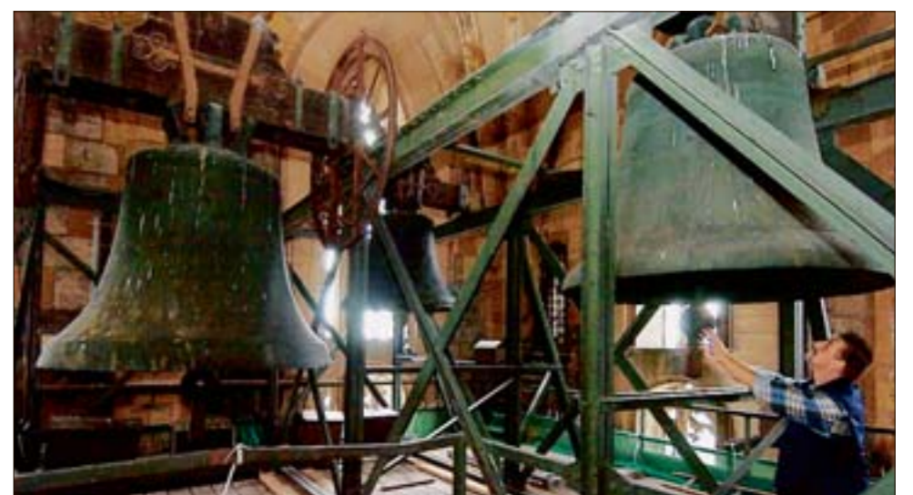
Das stumme Münster: Weil das Gestell des Glockenstuhls saniert werden muss, wird für die nächsten zwei Jahre kein Geläut mehr aus dem gotischen Wahrzeichen erklingen. Bild:dpa
